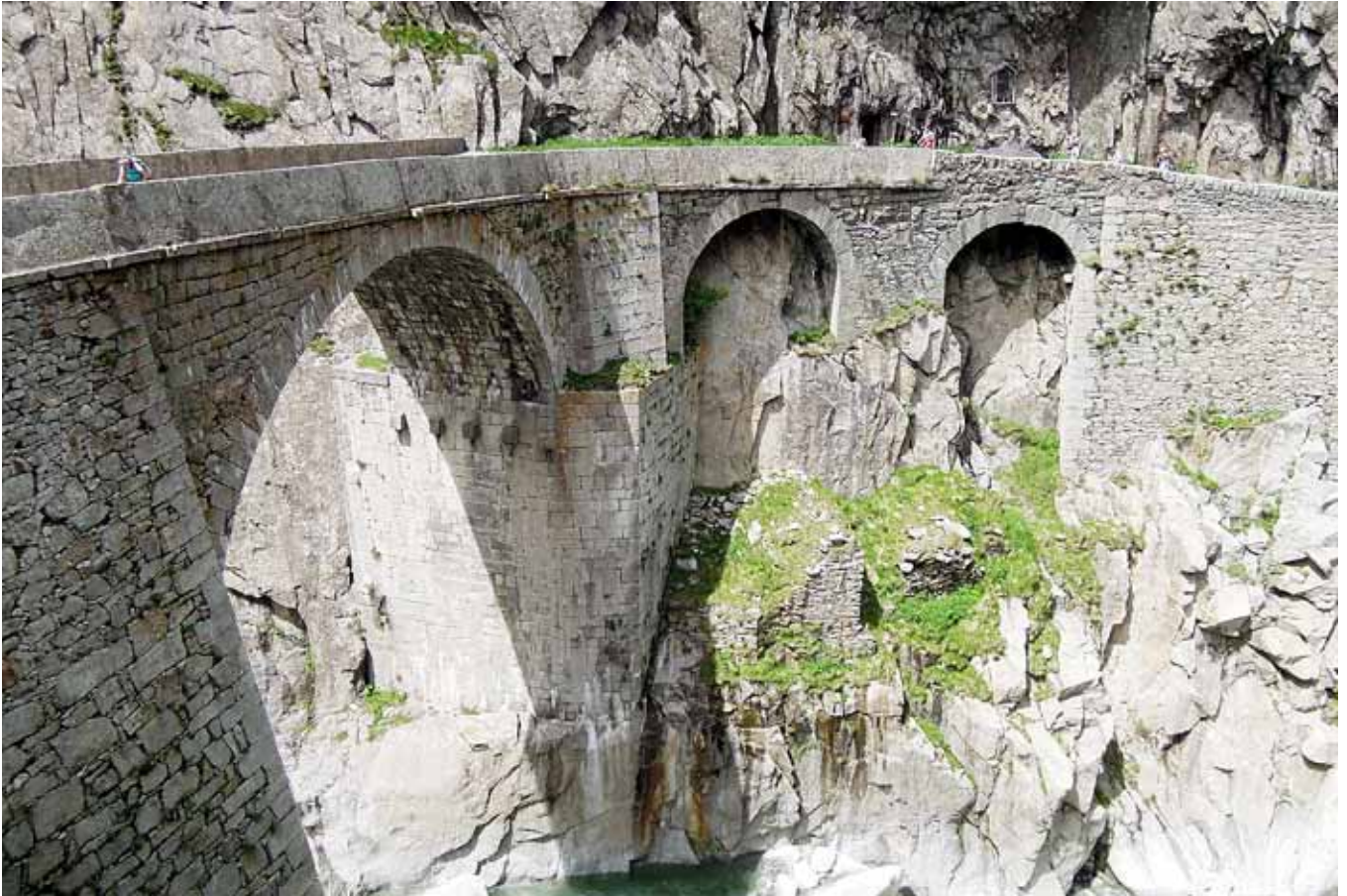
Ein faszinierender Anblick auf die alte Teufelsbrücke.
